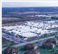
PANDUIT Corp. Tinley Park – Illinois – Estados Unidos
